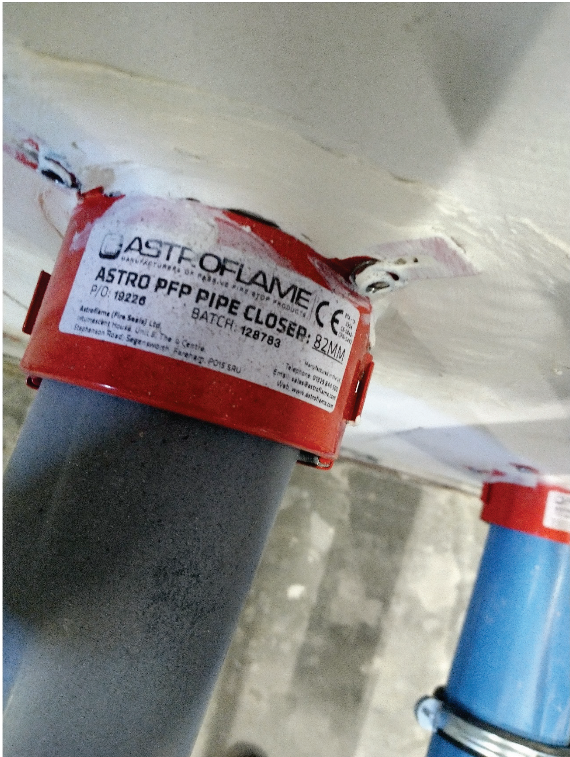
Foto 1 Manchet gemonteerd met wokkels in het steenwol schot
