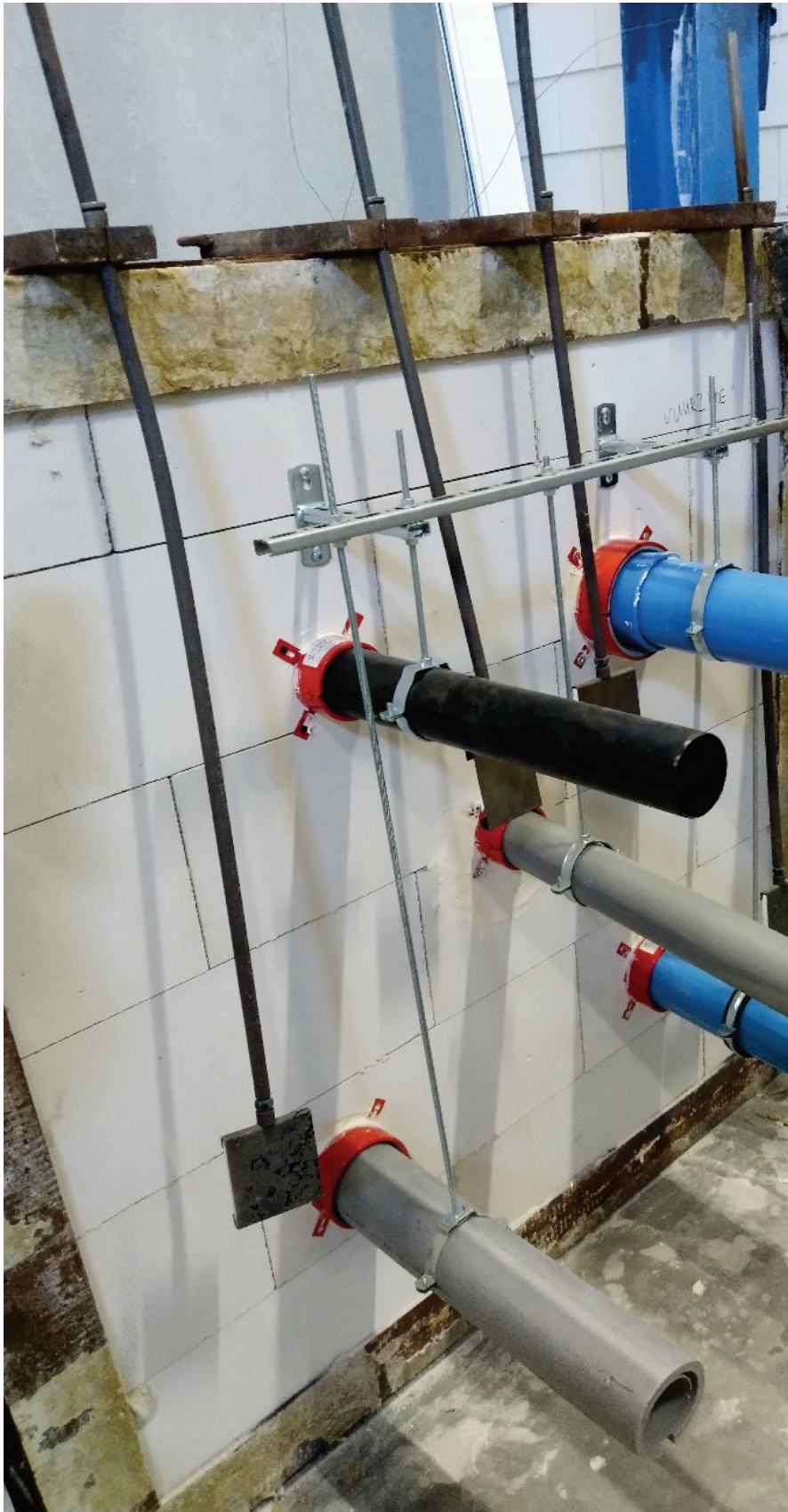
Foto 2 Overzicht van de proefstukken aan de verhitte zijde
